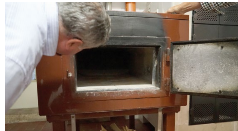
Top in Schuss: Sogar die Schamottesteine sind noch im Originalzustand.
